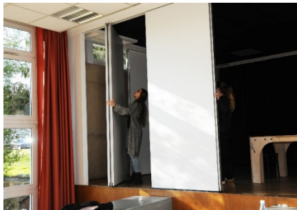
2017 ... die Erneuerung der Bühnen - Faltwand ca. 11.400,- Euro
